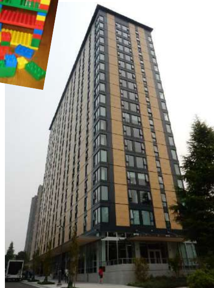
カナダ バンクーバー BROCK COMMONS UBC学生寮 18階木造 柱(集成材)と床(CLT)の構成 一部RC(エレベーターシャフト)
