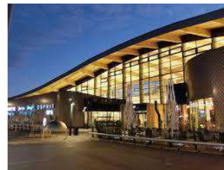
ショッピングモール CLT屋根
