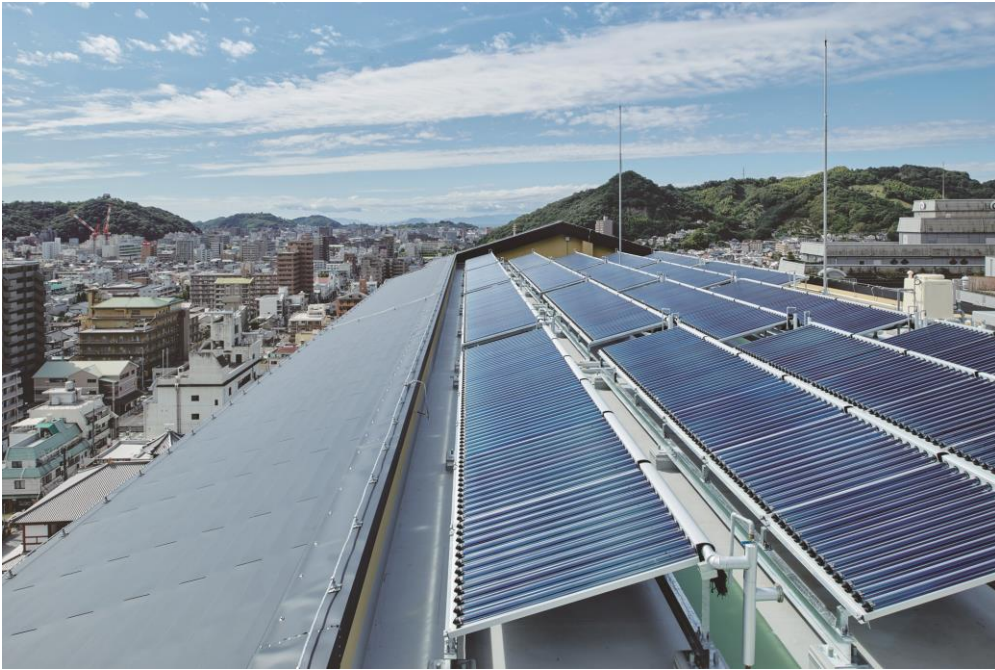
真空2重ガラス管式太陽熱集熱器(集光ミラー形):2.28㎡×108台
