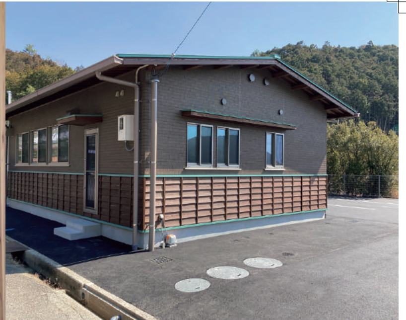
外装の仕上げなどにも木材を利用している
