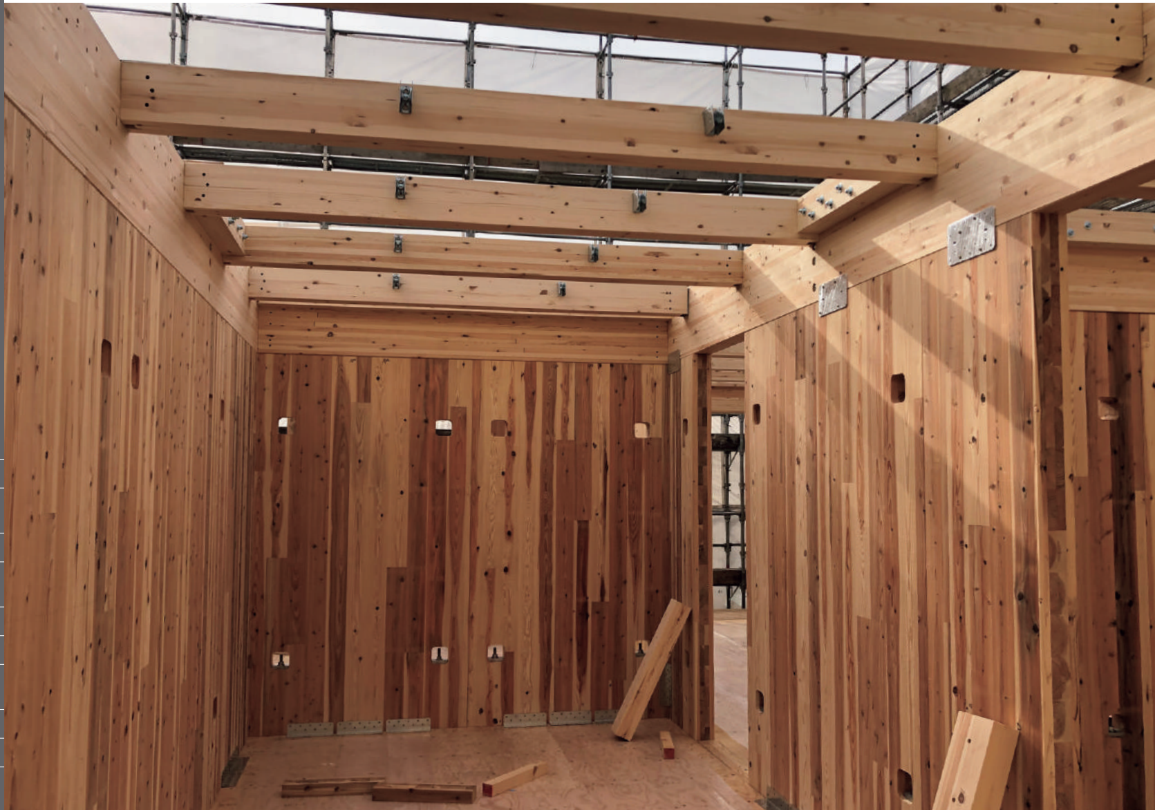
構造躯体にはCLTや県産材を活用
