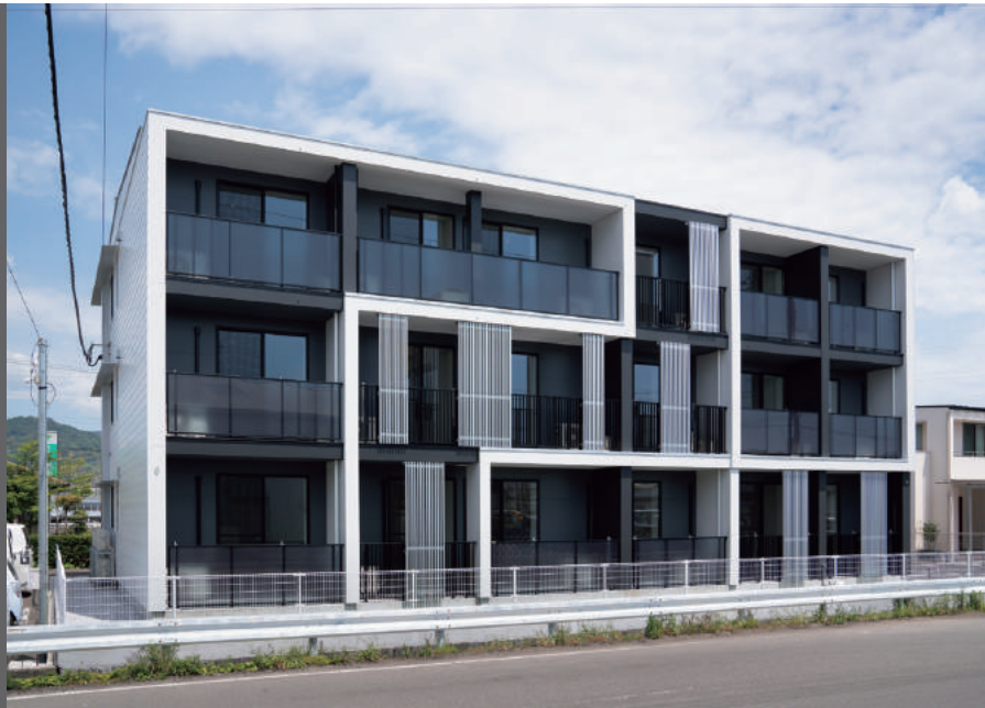
響建設がはじめてCLTを採用した賃貸共同住宅
