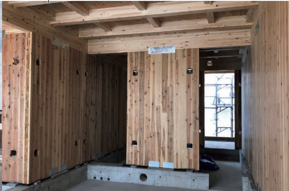
構造体壁にCLTを使用
