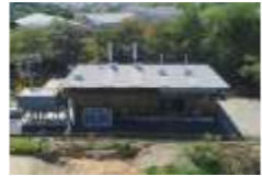
内子龍王バイオマス発電所外観。
