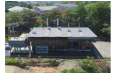
内子龍王バイオマス発電所外観。
