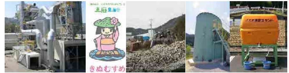
木質バイオマス発電施設 真庭里海米と瀬戸内海の牡蠣殻 バイオガス発電施設と液肥
