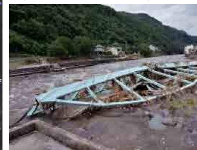
令和2年7月豪雨 大分県日田市の流された橋
