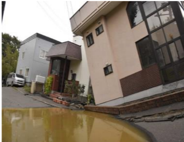
北海道胆振東部地震での被害の様子。
