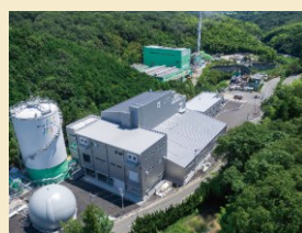
縦型乾式メタン発酵施設
